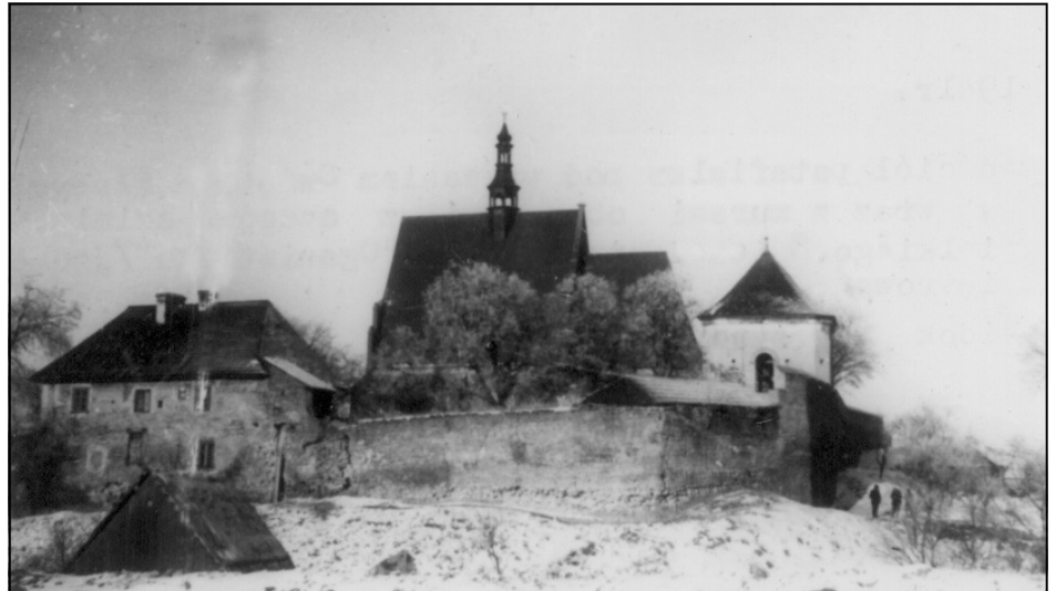
Kompleks kościelny na fotografii z 1941 r. Po lewej nieistniejący budynek wikarówki, w środku kościół, po prawej dzwonnica.
