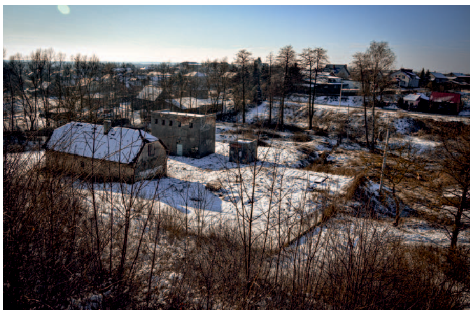
Teren starej oczyszczalni ścieków przed rewitalizacją na początku 2021 r. Widoczne na zdjęciu budynki zostały rozebrane.
