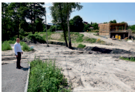
Budynek z tarasem widokowym i toaletami w trakcie budowy.
