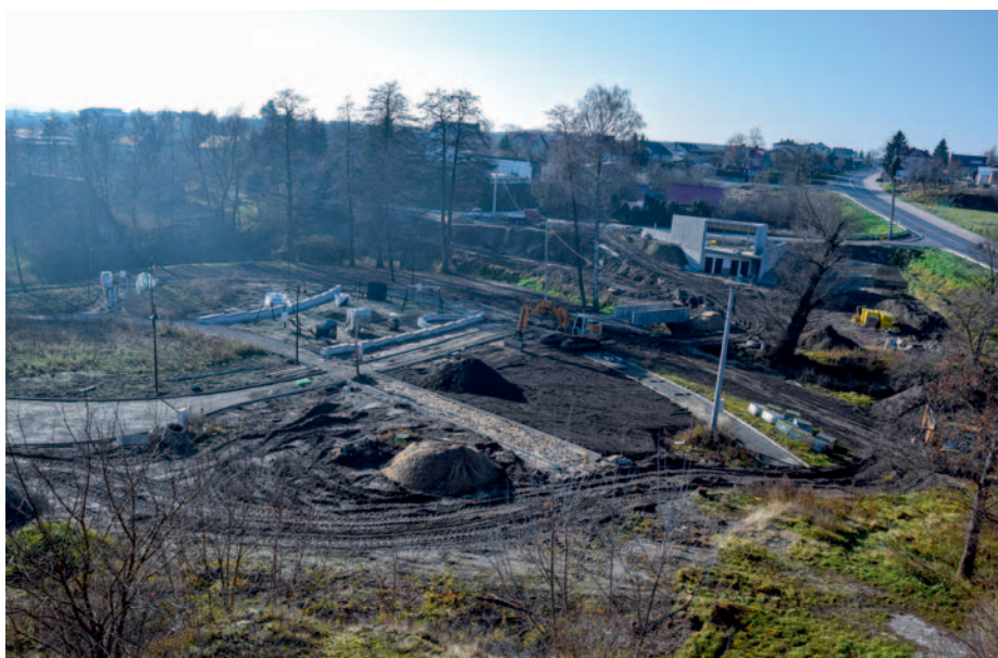
Teren budowanego parku pod koniec 2021 r. Po wykonaniu infrastruktury podziemnej, wytyczono aleje spacerowe i zainstalowano już pierwsze urządzenia siłowni zewnętrznej oraz wyposażenia placu zabaw.
