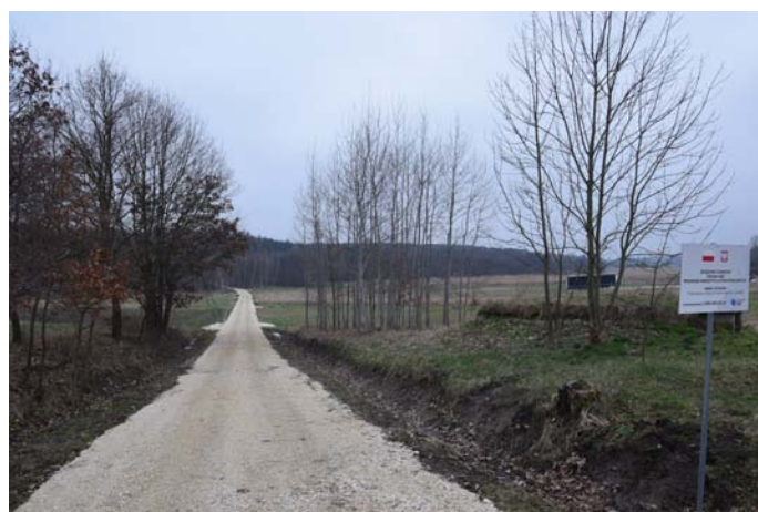
2023. Przebudowa drogi w Woli Podlesnej dz. 480.
