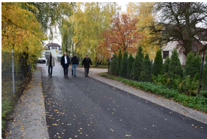
2022. Przebudowa drogi 39004T na dz. nr ew. 2512/2.
