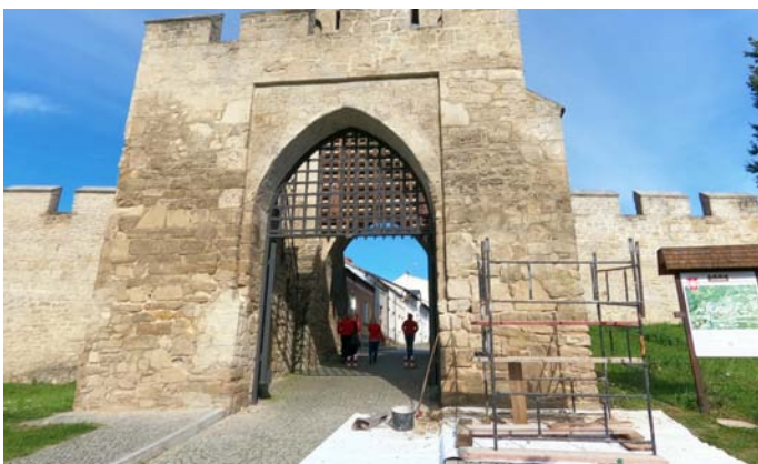
2020. Remont Bramy Krakowskiej.
