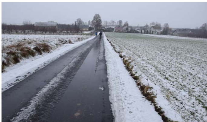
2021. Przebudowa drogi wewnętrznej nr ewid. dz. 644 w miejscowości Kotuszów (długość 535 m).
