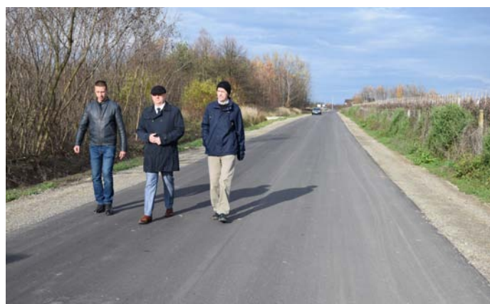
2019. Remont odcinka drogi gminnej nr 390030T Szydłów, ul. Urocza (449 m).
