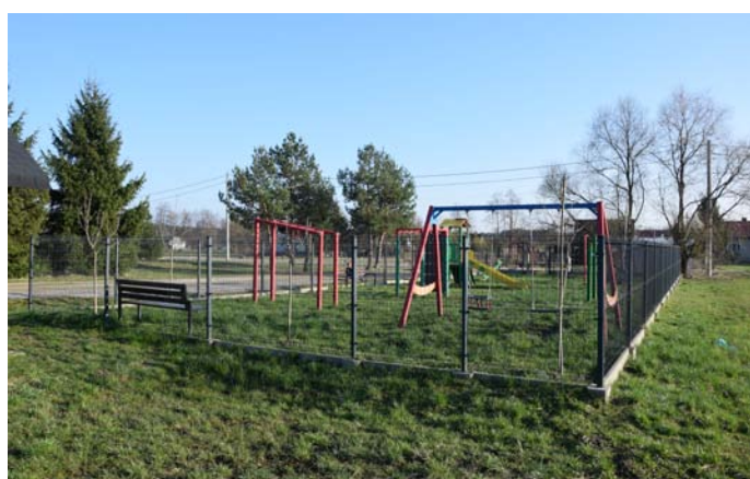
2019-2020. Plac zabaw i siłownia wraz z ogrodzeniem.
