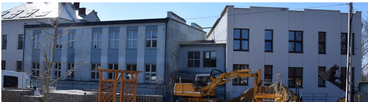
2022. Termomodernizacja Szkoły Podstawowej.
