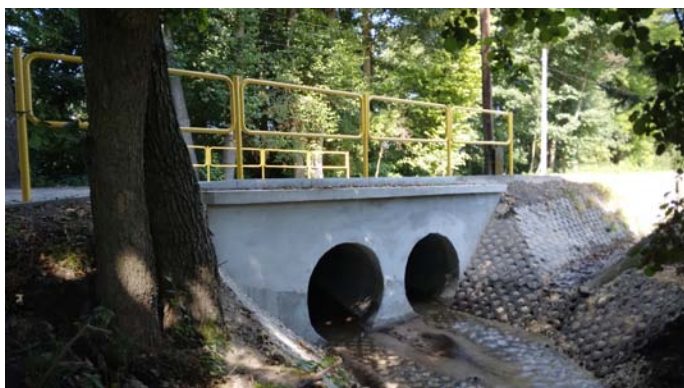
2023. Remont przepustu pod drogą powiatową nr 1012T, ul. Kazimierza Wielkiego.
