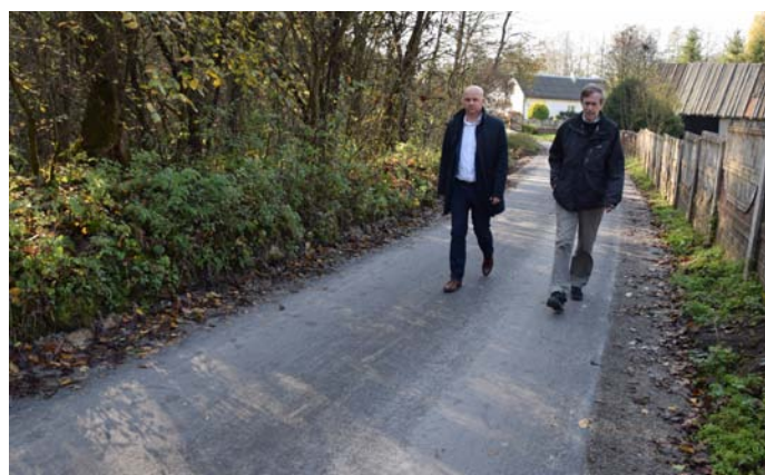
2019. Przebudowa drogi wewnętrznej nr ewid. 548 w Szydłowie od km 0+000 do km 0+133 (ul. Górki).
