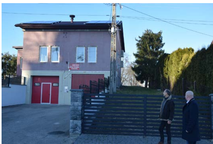
2023-2024. Poprawa efektywności energetycznej budynku OSP Kotuszów. docieplenie ścian zewnętrznych wraz ze zmianą kolorystyki elewacji budynku; docieplenie ścian fundamentowych 0,20 m poniżej poziomu gruntu; docieplenie ścian fundamentowych od poziomu gruntu do poziomu ław fundamentowych; docieplenie stropodachu; wymiana stolarki okiennej i drzwiowej; montaż pomp ciepła split i multisplit typu powietrze - powietrze; montaż fotowoltaiki; wymiana całej instalacji elektrycznej.
