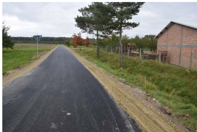
2021. Przebudowa drogi nr ewid. dz. 121.
