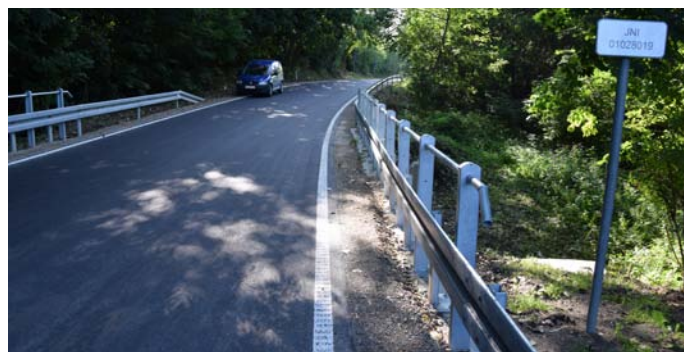
2023. Przebudowa drogi powiatowej 814T (0035T), ul. Brzezińskiej na długości 995 m. Wspólna inwestycja Powiatu Staszowskiego i Gminy Szydłów (gmina: 169 tys. zł.)
